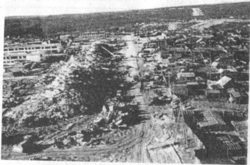
Рис. 31.4. Последствия землетрясения на севере о. Сахалин (г. Нефтегорск)
