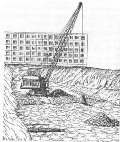
Рис. 24.1. Уплотнение лессовых просадочных грунтов в котловане тяжелой трамбовкой
