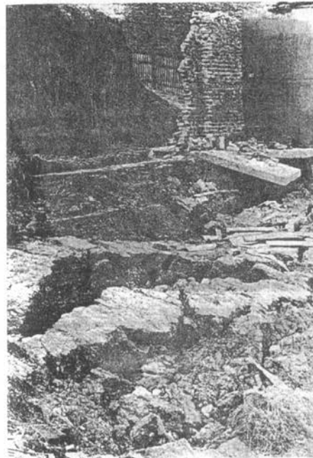
Рис. 28.1. Антропогенный оползень в районе г. Кисловодска
