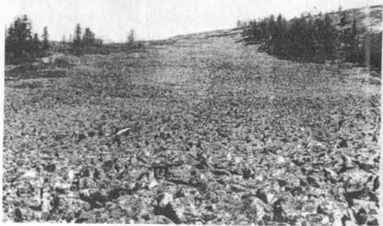
Рис. 29.4. Курумные покровы в Северном Забайкалье значительно осложняют строительство и эксплуатацию инженерных сооружений
