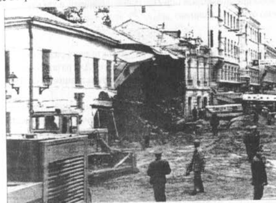
Рис. 27.5. Суффозионный провал (фото из архива ПНИИСа, г. Москва)
