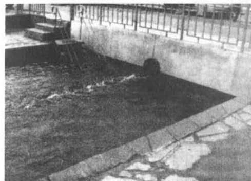
Рис. 13.15. Каптаж источника подземных вод
