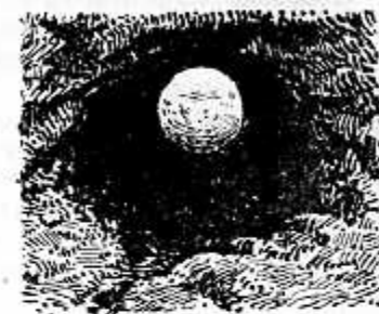
Рис. 119. Общий вид скважины пройденной вибровакуумным способом
