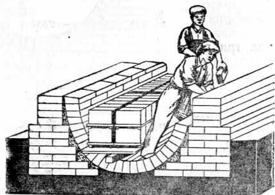
Рис. 50. Процессы кладки кирпичного канала
