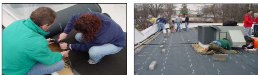
Рисунок 2-12. Слева - разрезание защитных слоев для укладки на крыше. Справа - укладка защитного слоя перед началом размещения на крыше слоя почвы.
