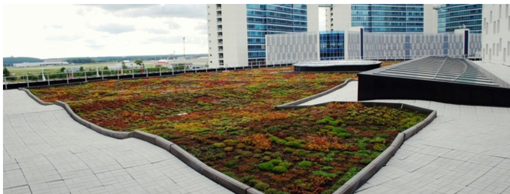
Рис. 2-8. Зеленая крыша комплекса "Аэропорт Сити".
