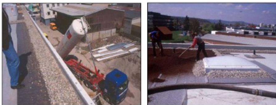
Рисунок 2-13. Пневматическая транспортировка грунта на крышу в Германии. Слева - грузовик, используемый для транспортировки грунта, справа - насосный шланг, используемый для подачи грунта на крышу, и рабочие, распространяющие его граблями.
