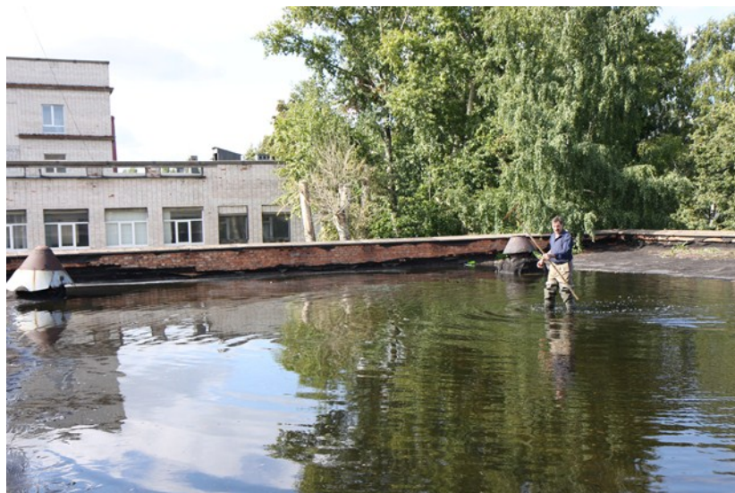
Рис. 3-13. Вид крыши лаборатории Гидрокорпуса-2.
