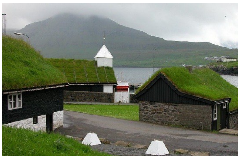
Рис. 2-1. Дома с дерновыми крышами на Фарерских островах.
